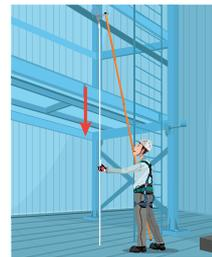
**g)** Após engatar o conector na estrutura, realize o mesmo procedimento apoiando o bastão de ancoragem em uma estrutura fixa ou com a ajuda de uma segunda pessoa para descer o bastão novamente.
